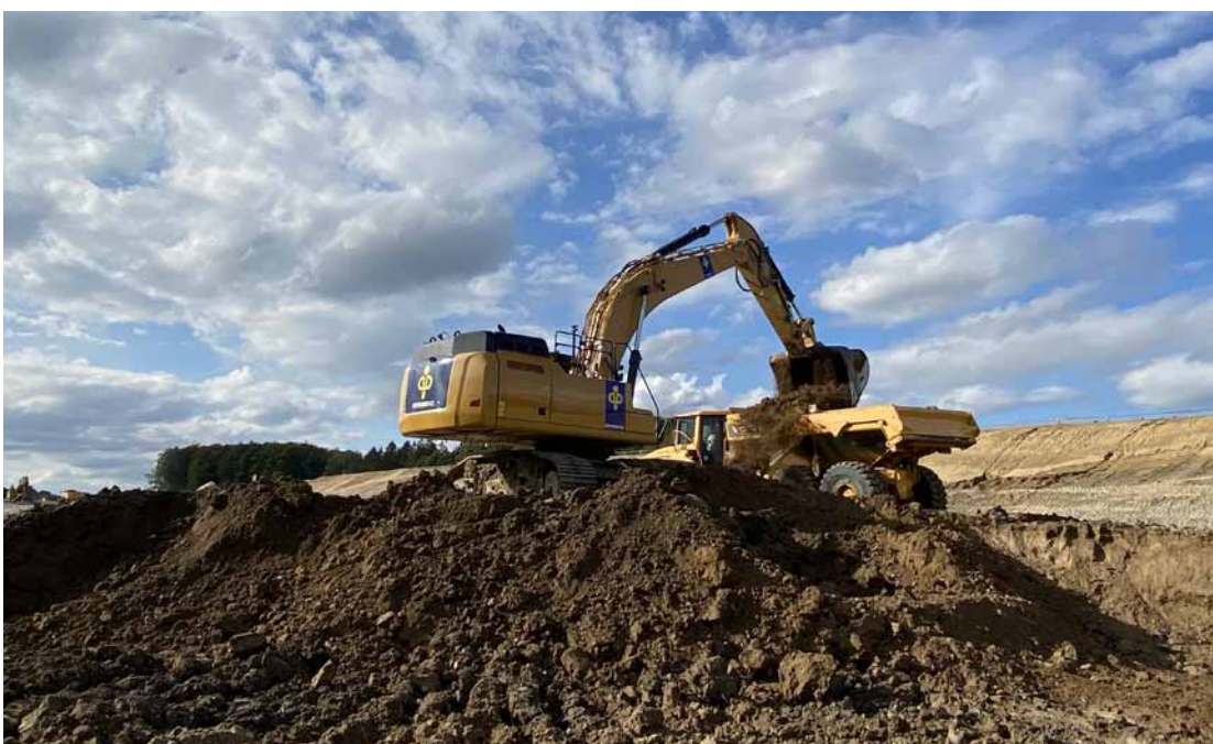
Täglich werden bis zu 6 000 Kubikmeter geladen, zu den Bodendeponien transportiert und dort mit hohen Anforderungen eingebaut.
