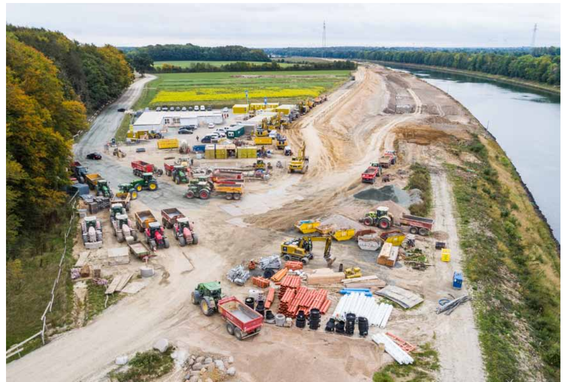
2 500 Meter Baustellenstraßen dienen der Material- und Geräteversorgung.
