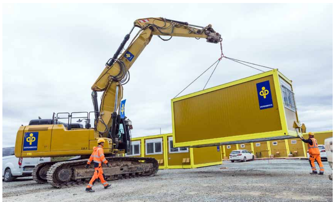
Die 6 000 Quadratmeter große Baustelleneinrichtungsfläche mit coronakonformen Baubüros wird eingerichtet.
