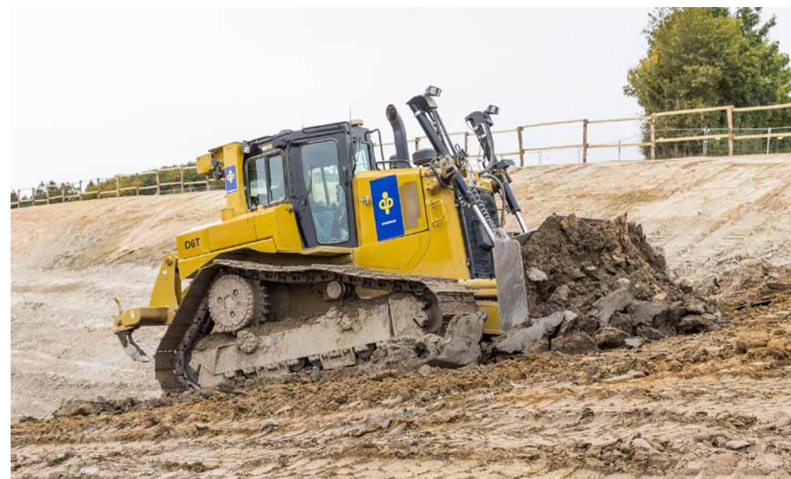
Das Bauunternehmen Depenbrock vertraut auf Cat Raupen wie eine D6T, die den Boden in den Ablagerungsflächen einbauen, Böschungen profilieren und Oberböden abtragen.
