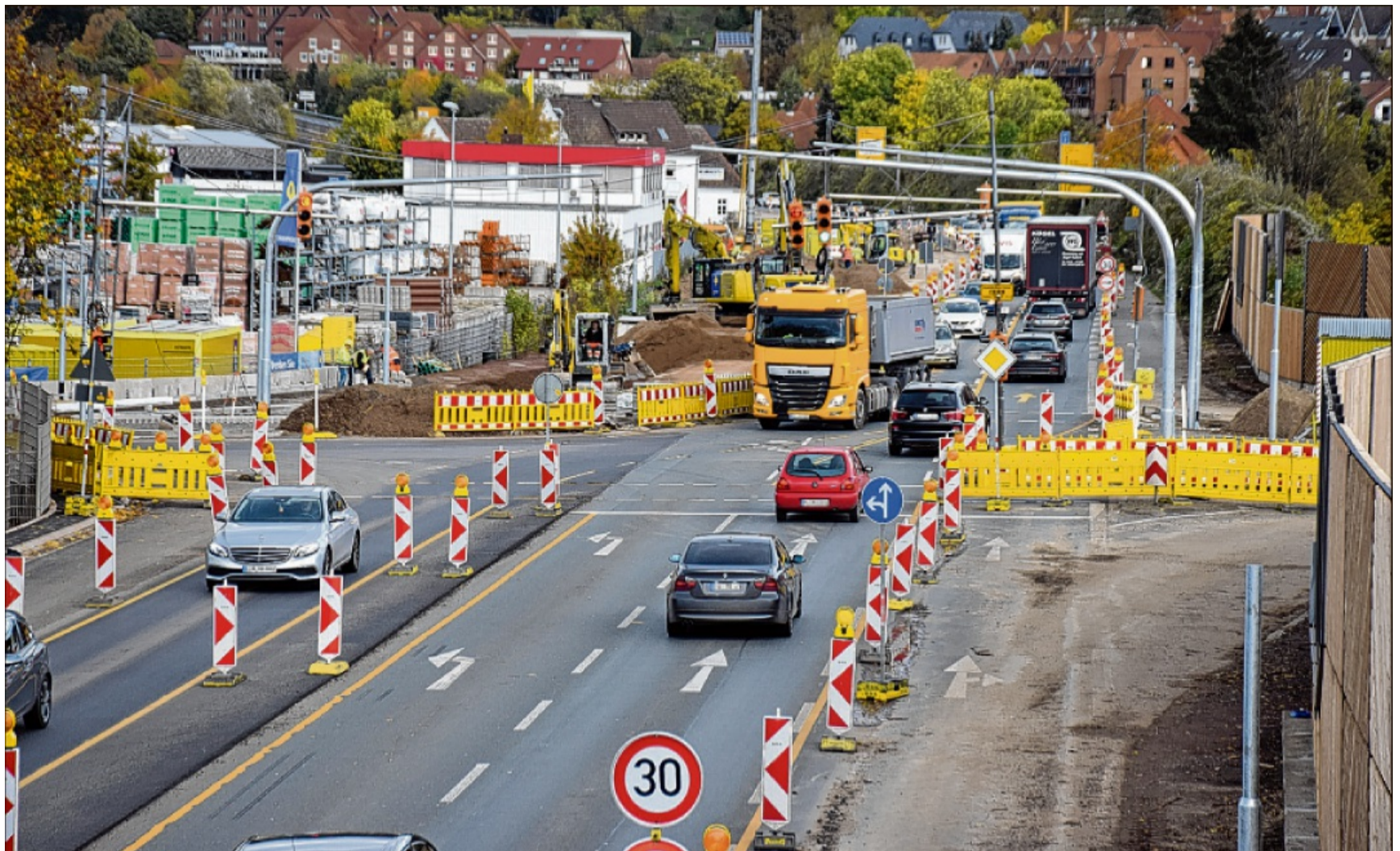
Blick von oben: Die Baustelle auf der B 482 ist eine große Herausforderung. Denn während der gesamten Maßnahme rollt der Verkehr durch die Baustelle. Noch in diesem Jahr soll der Kreuzungsbereich wieder komplett freigegeben werden. MT-Fotos: Thomas Lieske
