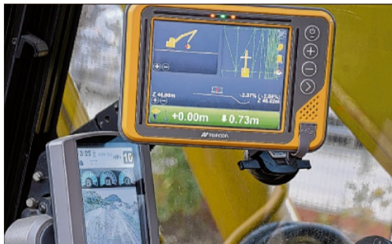
Mit Kamera und GPS-Technik lässt sich die Schaufel des Baggers zentimetergenau steuern.
