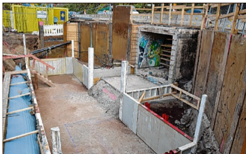
Noch eine Großbaustelle: Der Tunnel für die Fußgänger muss deutlich verlängert werden.
